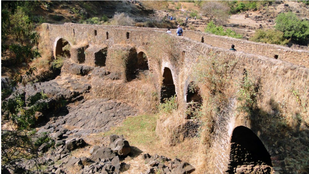
Fot. 5. Siedemnastowieczny kamienny most poniżej wodospadu Tys Ysat nad niemal suchym w tym miejscu korytem Błękitnego Nilu; Etiopia (fot. P. Jokiel 2018)
