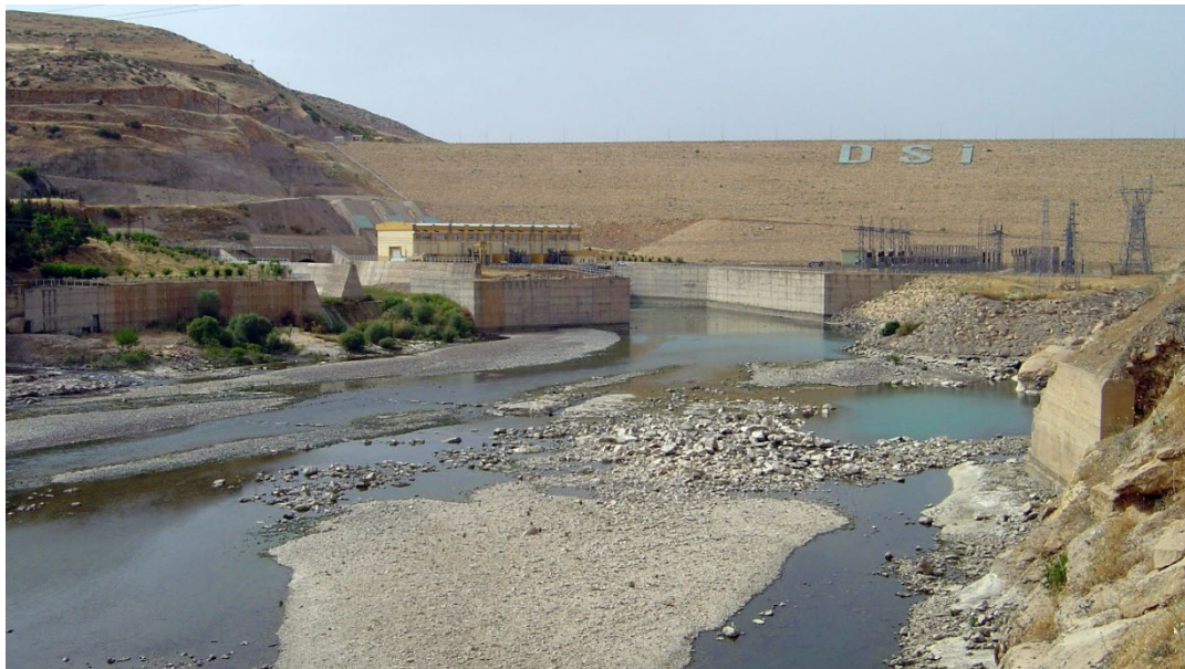
Fot. 13. Zapora na rzece Batman – element kontrowersyjnego systemu zaboru wody z dorzecza Eufratu; Turcja (fot. P. Jokiel 2009)
